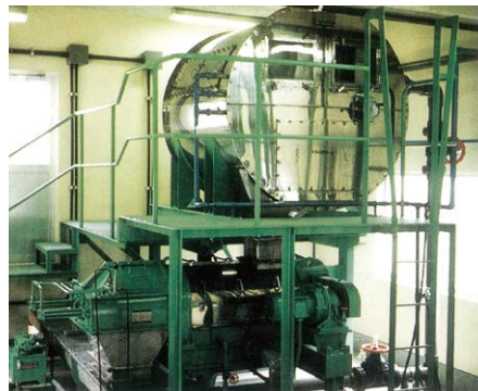
栗野町・吉松町衛生処理施設(鹿児島県)
