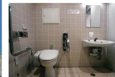
多目的トイレ
